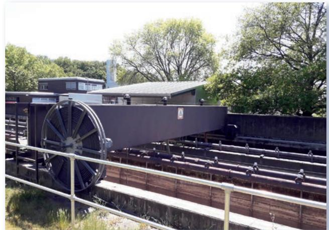
Umfangreichere Überholungsarbeiten an den Laufschienen, den Pumpen und den Räumlerbrücken erforderten im Laufe des Jahres die sukzessive Außerbetriebnahme der beiden Sandfänge des **KLÄRWERKS SOLINGEN-OHLIGS**.
