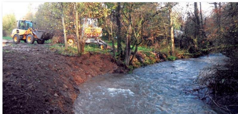
Um einen Anschluss an den vorhandenen Untergrund zu bekommen, wurde das Material im Anschluss mit einer etwa zwei Tonnen schweren Stahlkugel verdichtet. Hierbei war es wichtig, ein gleichmäßiges Sohlgefälle von Ober- nach Unterwasser herzustellen, damit sich später die erforderlichen Wasserstände und Fließgeschwindigkeiten einstellen können.
