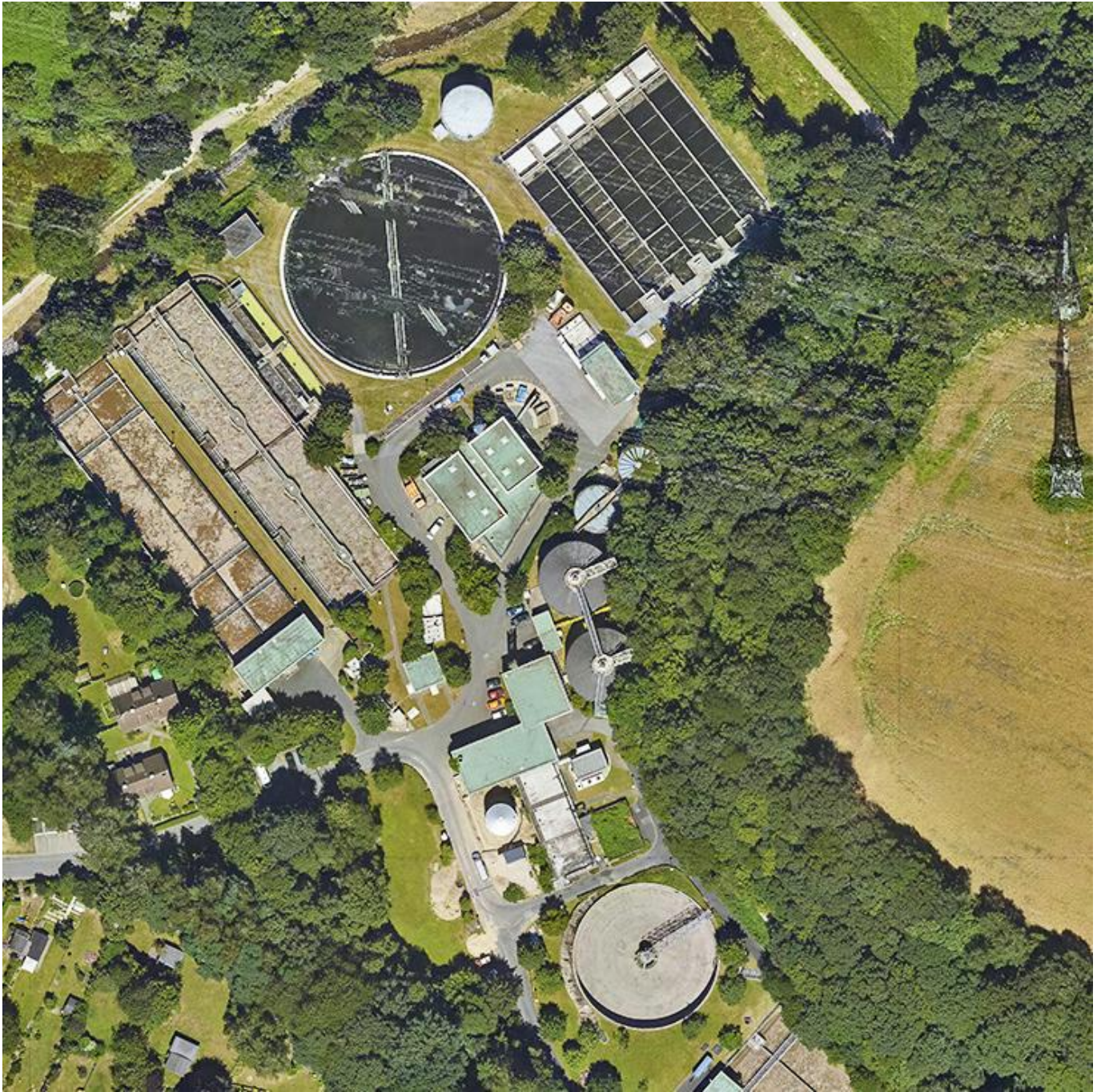
Luftbild Kläranlage Solingen-Ohligs
