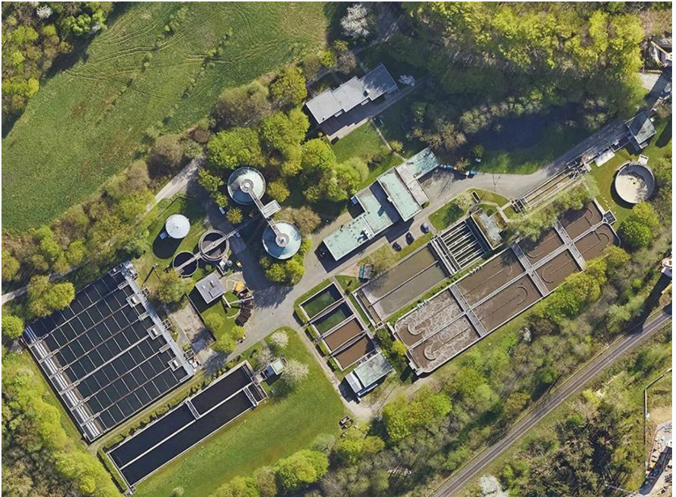
Luftbild Kläranlage Angertal
