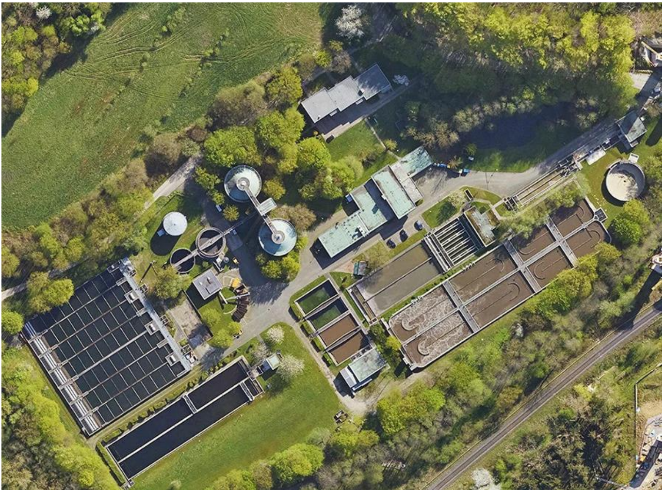
Luftbild Kläranlage Angertal
