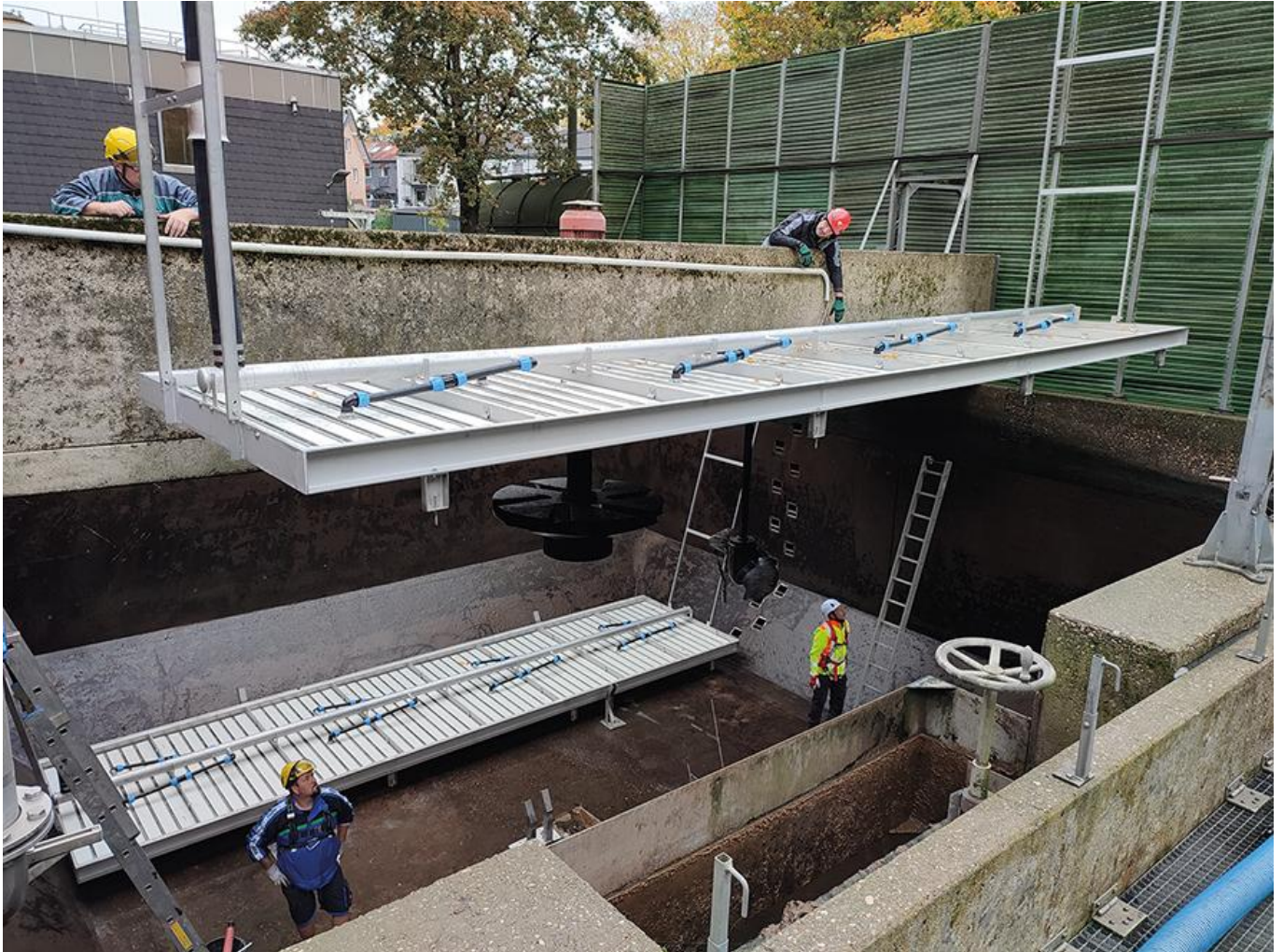
Einheben der Membrangestelle Belüftung Belebungsbecken Klärwerk Tönisheide
