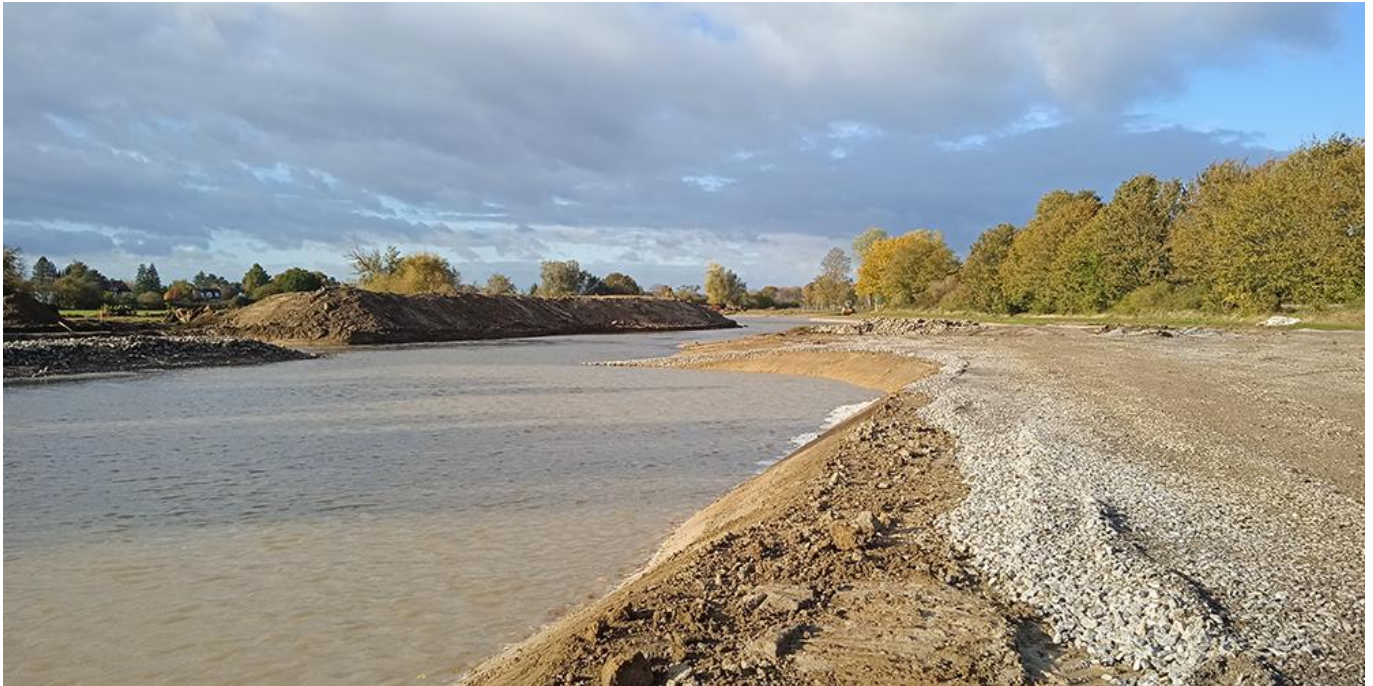
Foto im Bau - Umschluss Teilabschnitt 6
